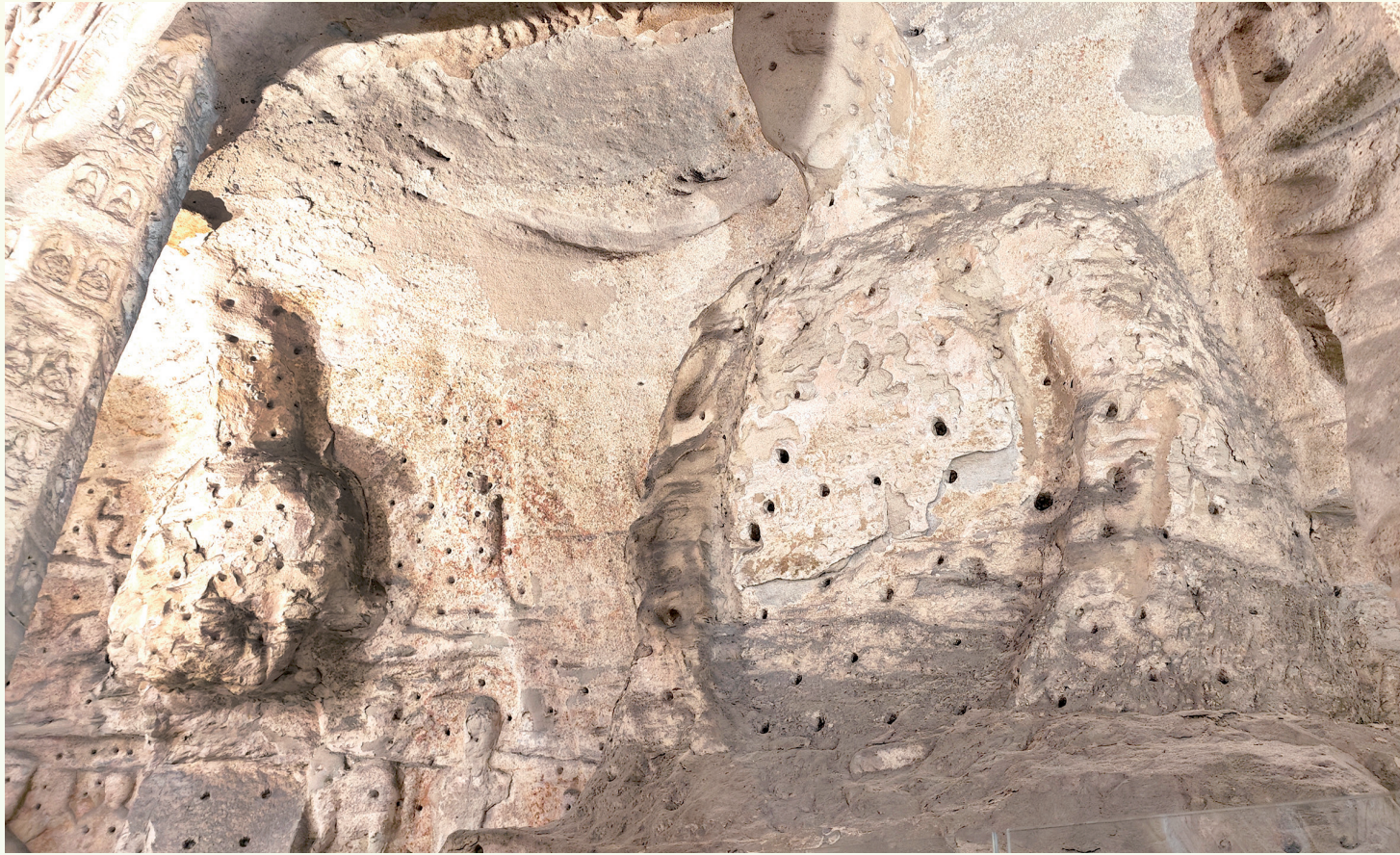
云冈石窟第六窟靠近山体的北壁受气候影响较大,被侵蚀痕迹明显。
