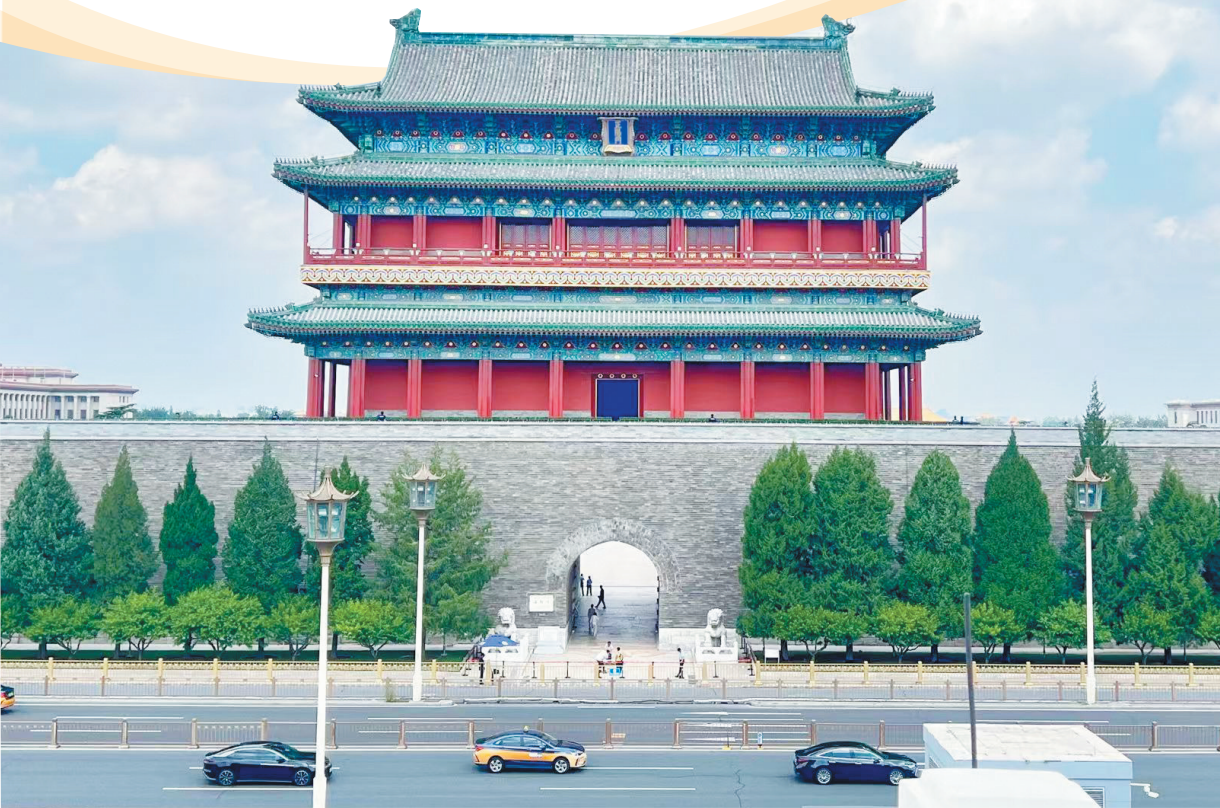
修缮后的正阳门对公众开放。
