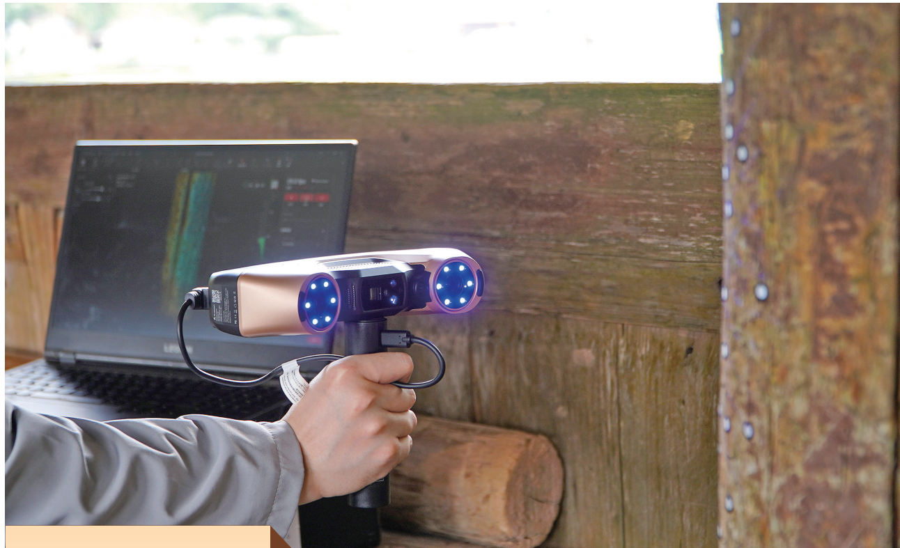
工作人员用三维扫描仪记录木构件典型病害三维影像。应 腾 摄
