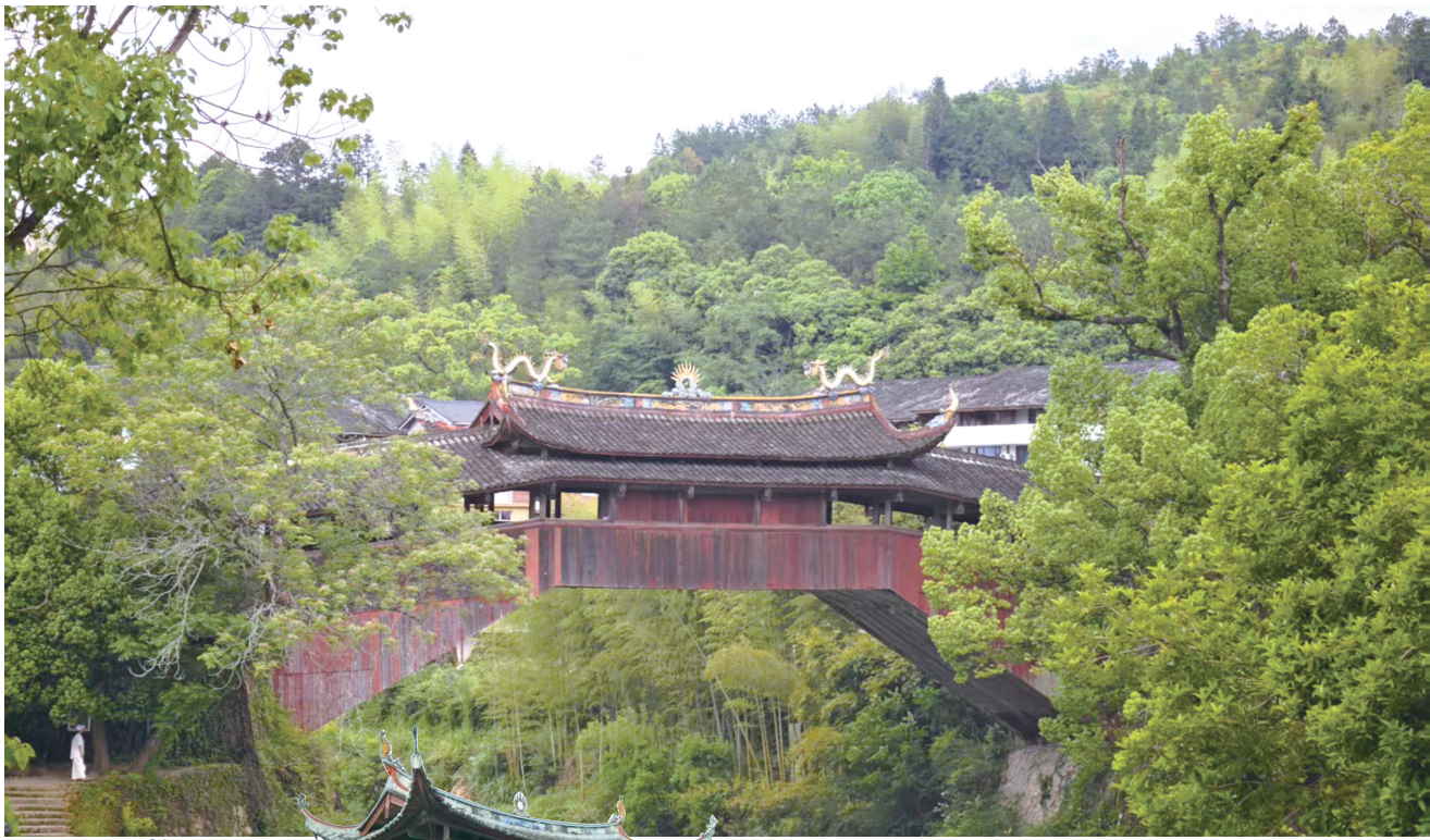
▲ 位于泰顺县泗溪镇下桥村的北涧桥。
